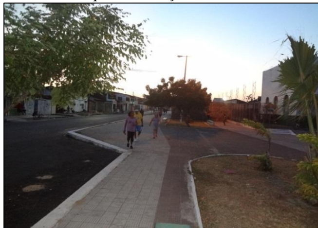
Figura 05: Lateral esquerda da Praça de Santa Cecília- Bom Jardim.
